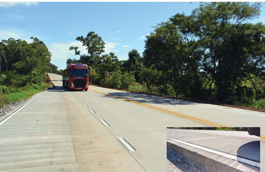
Rodovia está recebendo pavimento em concreto com 25 cm de espessura
